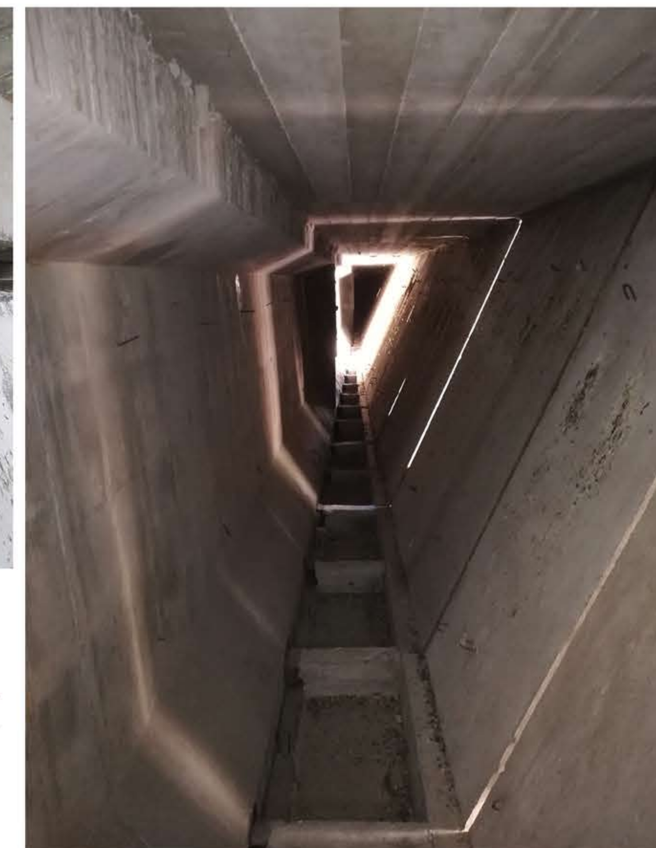
Ispezione delle travature
