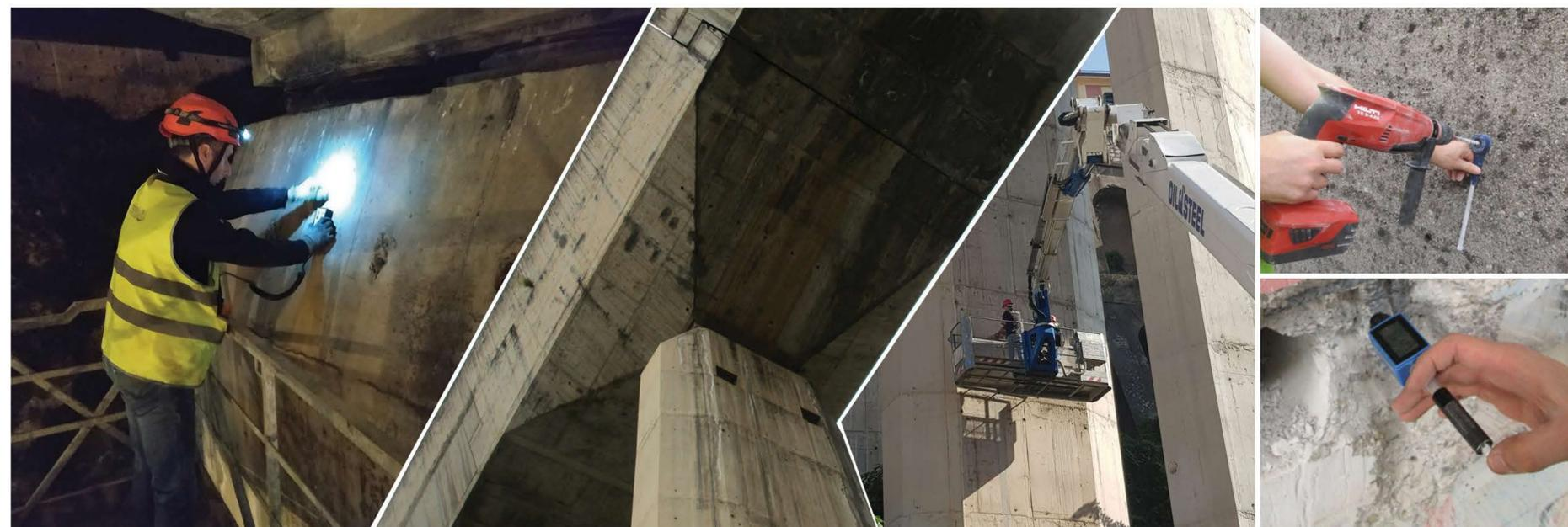
Esecuzione di indagini in quota mediante piattaforma elevatrice e by bridge
